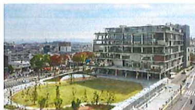
おにクルの外観の様子。
