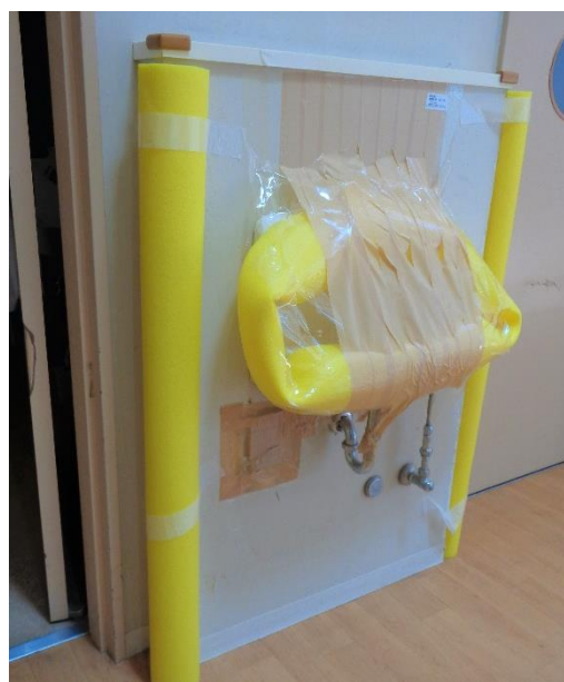
写真 12 ウレタン棒で覆った洗面台の様子
